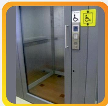
**Лифт для людей с инвалидностью.** Кнопки вызова лифта и управления его движением должны быть крупными, с рельефными цифрами и располагать на высоте от пола не более 1,2 м. У каждой двери лифта – информирующая сигнализация (световая и звуковая), должны быть тактильные указатели уровня этажа, двусторонняя связь из кабины лифта с диспетчером или дежурным и аварийное освещение. Может устанавливаться как внутри, так и снаружи здания.
