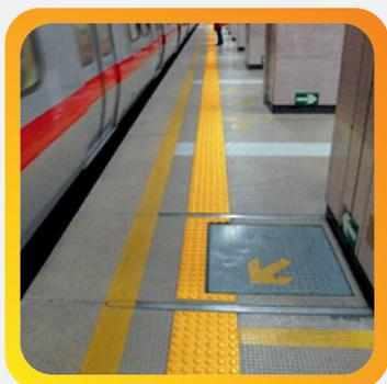
**Тактильный наземный указатель** – средство отображения информации, представляющее собой полосу из различных материалов определенного цвета и рисунка рифления, позволяющих инвалидам по зрению распознать типы дорожного покрытия путем осязания стопами ног, тростью или используя остаточное зрение.
