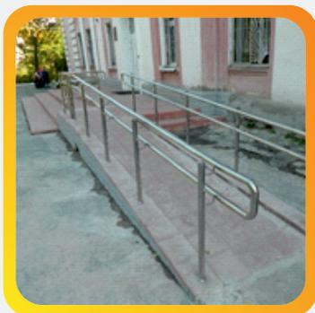
**Пандус** – это наклонная поверхность для перемещения колясок. Компенсирует перепады высоты в местах передвижения и внутри помещения.
